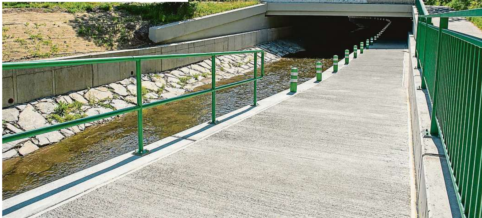
A26 je páteřní cyklotrasa z Libně od vltavské pravobřežní trasy A2 podél říčky Rokytky přes Vysočany do Hloubětína, na Černý Most a Horní Počernice. TSK
