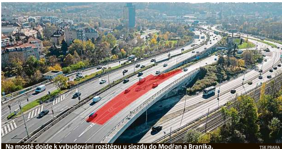
Na mostě dojde k vybudování rozštěpu u sjezdu do Modřan a Braníka.
