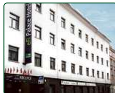
eFi Palace Hotel, Brno, dokončené 2 etapy
