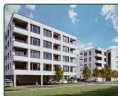
Bytové domy Břeclav, ul. Charvátská
