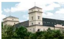
Zámek Račice, přestavba
