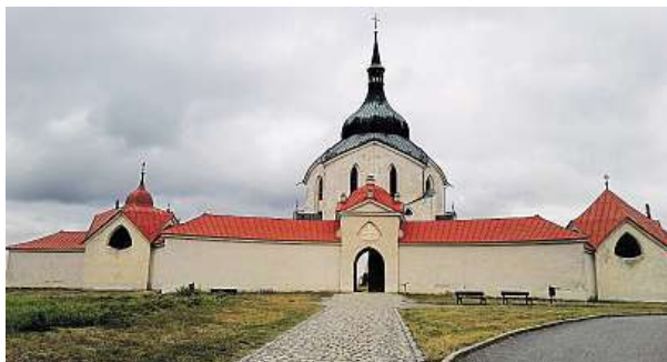
Poutní kostel sv. Jana Nepomuckého na Zelené Hoře METRO
