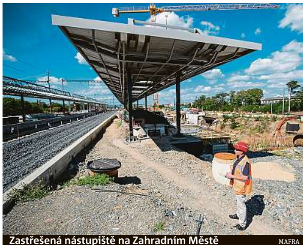
Zastřešená nástupiště na Zahradním Městě
