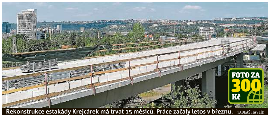
Rekonstrukce estakády Krejčárek má trvat 15 měsíců. Práce začaly letos v březnu.
