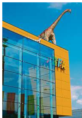
Modely na střeše Galerie Harfa jsou k vidění i z ulice.
