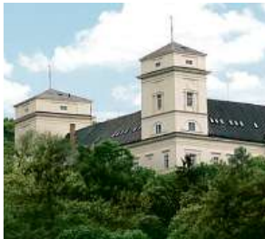
Zámek Račice, přestavba
