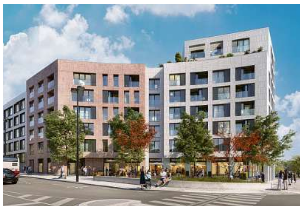
Unikátně řešený bytový dům obložený kamenem dotvoří Basilejské náměstí
