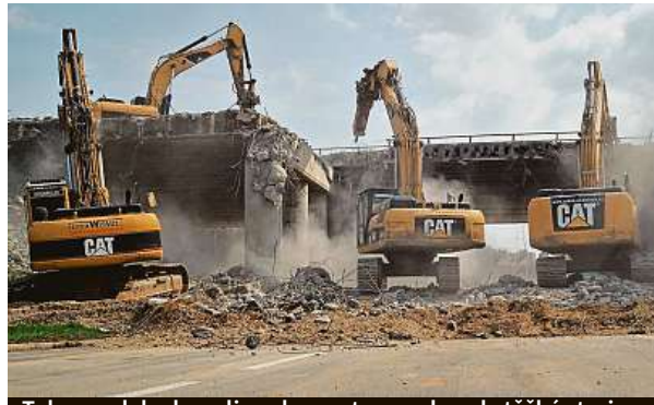
Tak vypadala demolice, do mostu se zakously těžké stroje.
