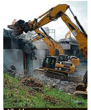
Likvidace mostu 2x RSD
