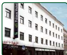
eFi Palace Hotel, Brno, dokončené 2 etapy
