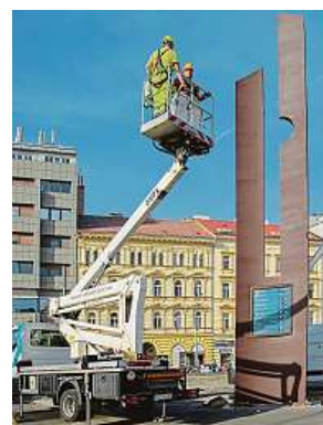
Nová konstrukce je na Florenci umístěna od konce září. 3x THMP
