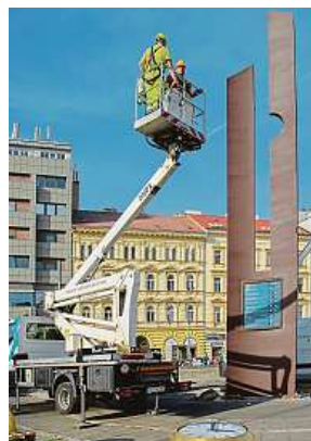
Nová konstrukce je na Florenci umístěna od konce září. 5x THMP
