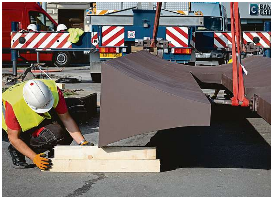
Před uvedením do provozu bude ocelová konstrukce opatřena ještě antigraffiti nátěrem, který přispěje k prodloužení její životnosti. V uplynulých dnech byly do horní části osazeny pozlacené hodiny.
