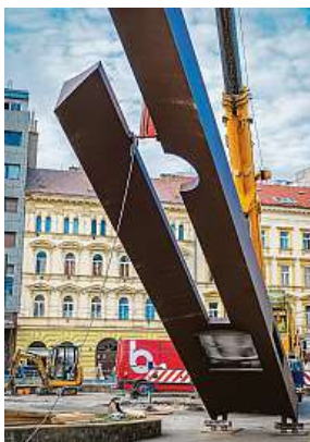
Oprava unikátní plastiky se protáhla na více než tři roky.
