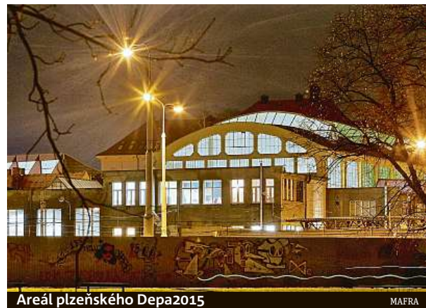
Areál plzeňského Depo2015
