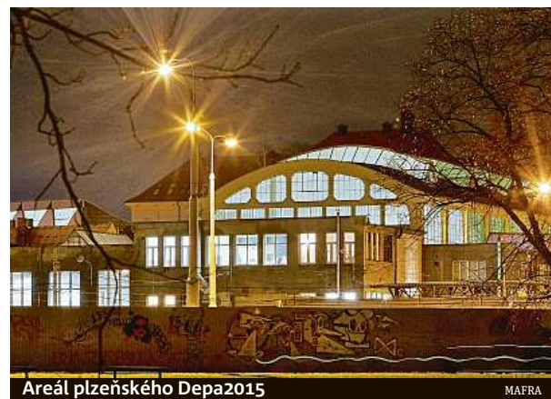
Areál plzeňského Depo2015
