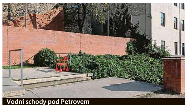
Vodní schody pod Petrovem
