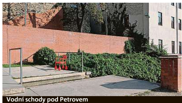
Vodní schody pod Petrovem
