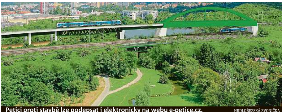
Petici proti stavbě lze podepsat i elektronicky na webu e-petice.cz.
