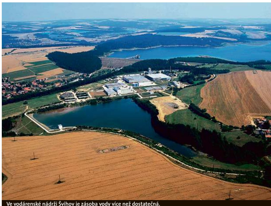
Ve vodárenské nádrži Švihov je zásoba vody více než dostatečná.
