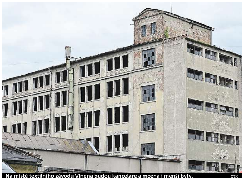
Na místě textilního závodu Vlněna budou kanceláře a možná i menší byty.
