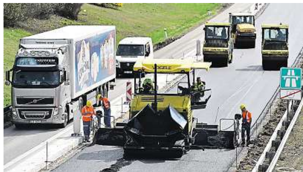
Práce probíhají i na dálnici D1 směrem na Prahu. ČTK
