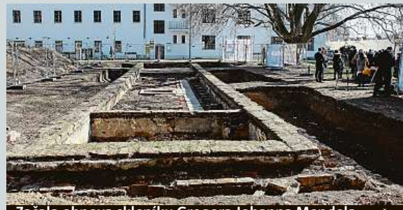
Začala obnova skleníku Gregora Johanna Mendela. 2x ČTK
