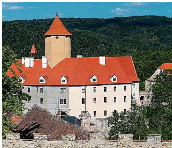
Střechy se budou opravovat do konce příštího roku. MAFRA
