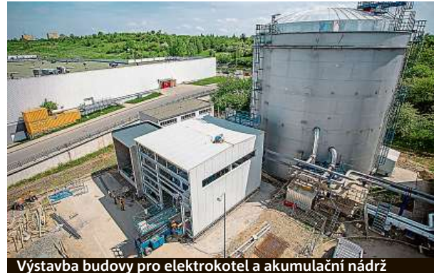
Výstavba budovy pro elektrokotel a akumulaci nádrže
