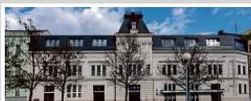
Multifunkční budova, Brno
