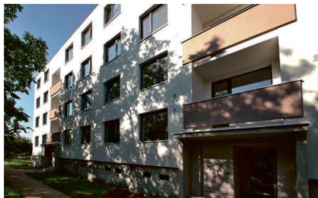
Investiční byty v zrekonstruovaném domě v Brně-Chrlicích.
