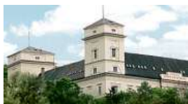
Zámek Račice, přestavba
