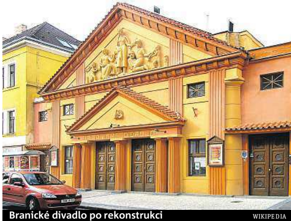
Branické divadlo po rekonstrukci
