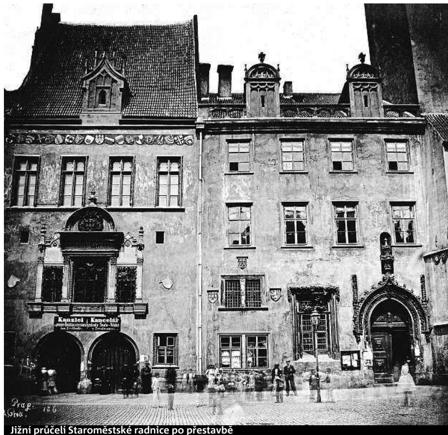
Jižní průčelí Staroměstské radnice po přestavbě
