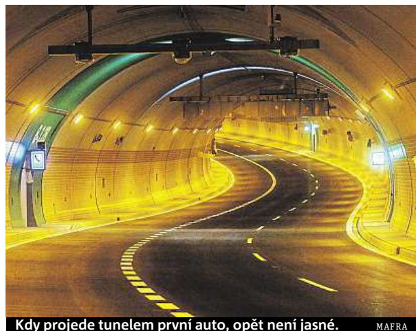
Kdy projede tunelem první auto, opět není jasné.
