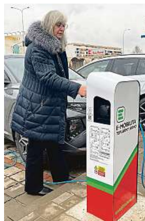
Dobíjecí stanice u lužáneckých bazénů TEPLÁRNY BRNO
