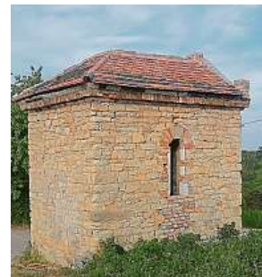
Na fotografii je vidět současný stav kaple v Evaňi. 2x KAPLIČKÁŘI
