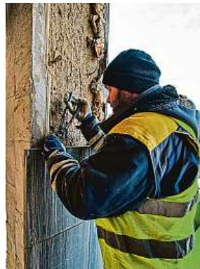
V první fázi dělníci odstraňovali omítky, podlahové krytiny a prováděli další bourací práce.
