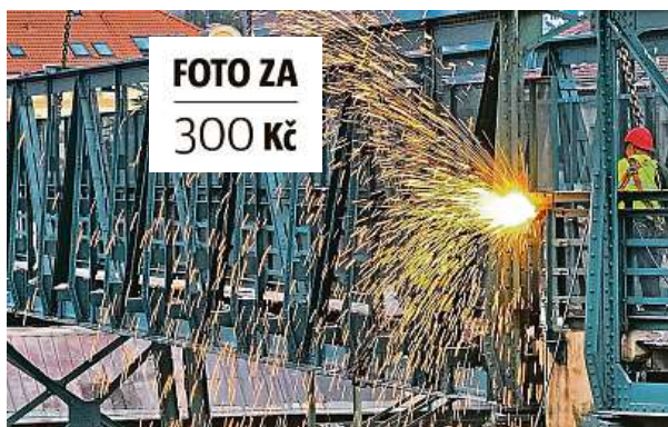
Demontáž další části radlické/smíchovské lávky nad severním nástupištěm smíchovského nádraží
