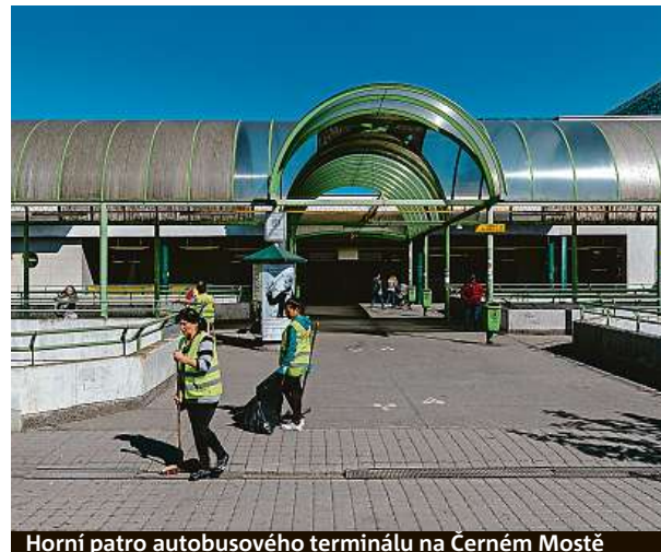
Horní patro autobusového terminálu na Černém Mostě
