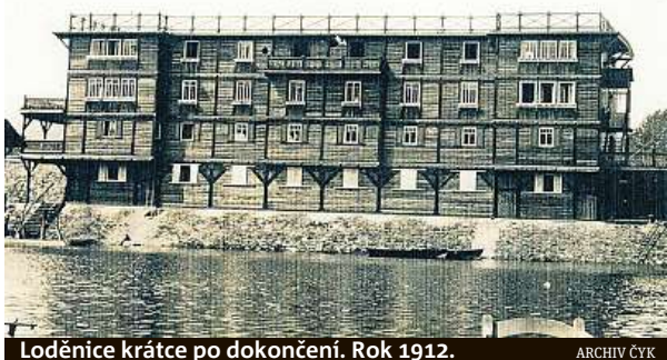
Loděnice krátce po dokončení. Rok 1912.
