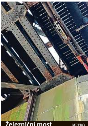
Železniční most METRO
