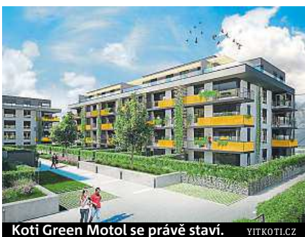
Koti Green Motol se právě staví.
