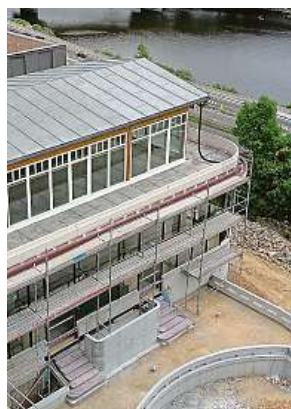
Funkcionalistická stavba se vrací do své původní podoby.
