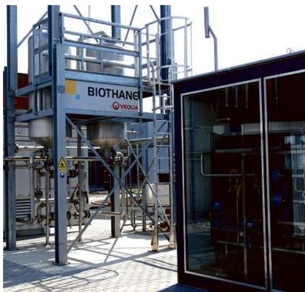
K úpravě bioplynu na bioCNG slouží jednotka využívající membránovou technologii MemGas TM skupiny Veolia.
