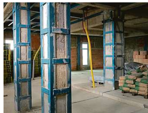
Betonové sloupy v podzemí musela vyztužit ocelová konstrukce. Hodně se rekonstruovalo podle fotografií.
