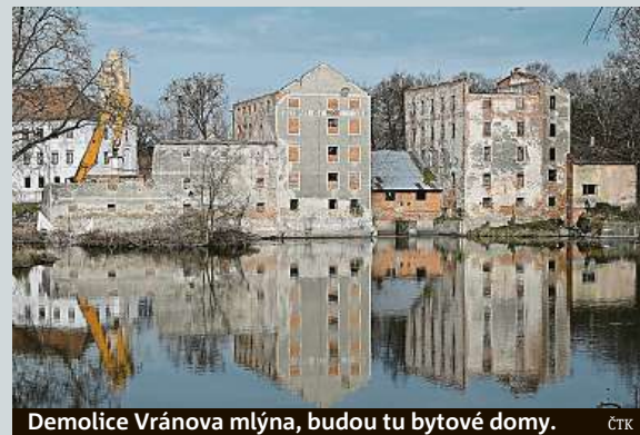
Demolice Vránova mlýna, budou tu bytové domy. ČTK
