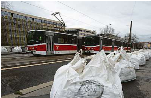
Zatěžkávací zkoušky na Libeňském mostě
