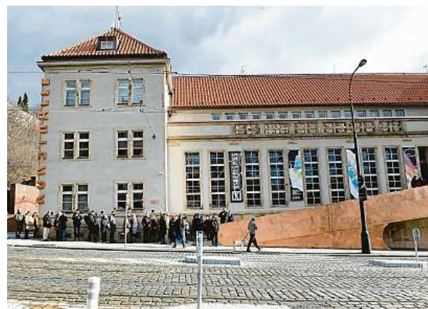
Z bývalé trafostanice na Klárově je nyní výstavní objekt.
