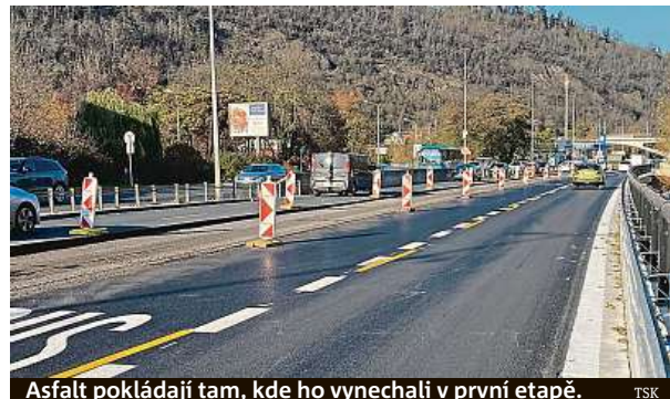
Asfalt pokládají tam, kde ho vynechali v první etapě.
