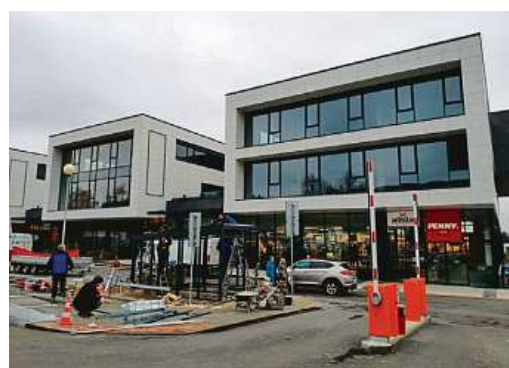
Rekonstrukce původního objektu začala na podzim 2018, vestavba prodejny PENNY v září 2019.
