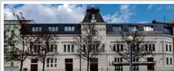
Multifunkční budova, Brno
