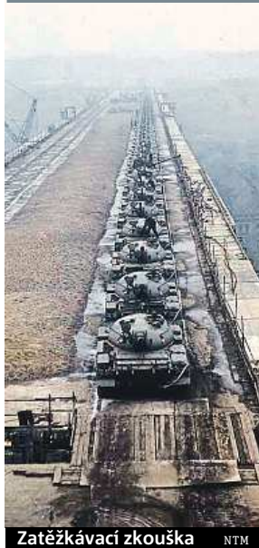
Zatěžkávací zkouška NTM
