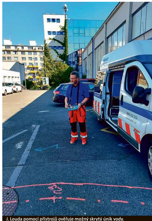
J. Louda pomocí přístrojů ověřuje možný skrytý únik vody.
