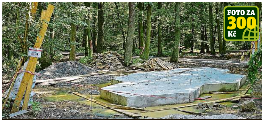
Altán, který byl ve špatném stavu, nahradí nový. Momentálně tu jsou jeho základy. JAN GROF
