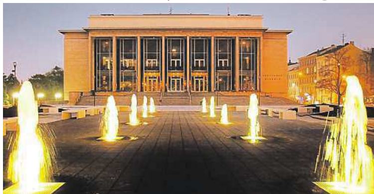
Budova je v havarijním stavu, obkladové desky praskají a opadávají. MAFRA
