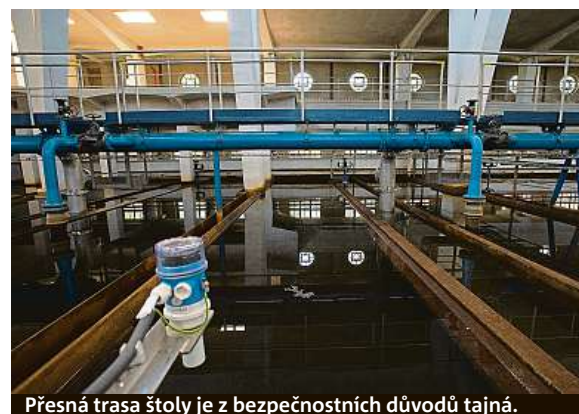
Přesná trasa štolky je z bezpečnostních důvodů tajná.
